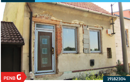
PENB G 19182304 Dům 3+kk s garáží v probíhající rekonstrukci, včetně materiálu, CP: 821m2
